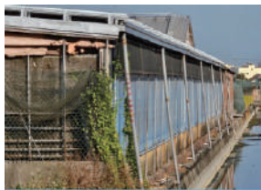
雨水 - 增設雨水槽
